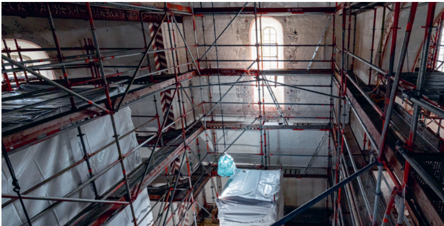
Blick in den eingerüsteten Chorraum
