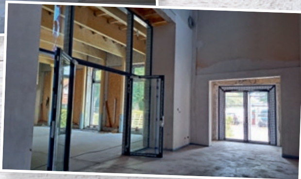
Neuer Eingangsbereich und Durchgang zum Saal
